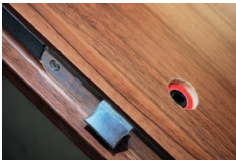
detail zámku protipožárních dveří
