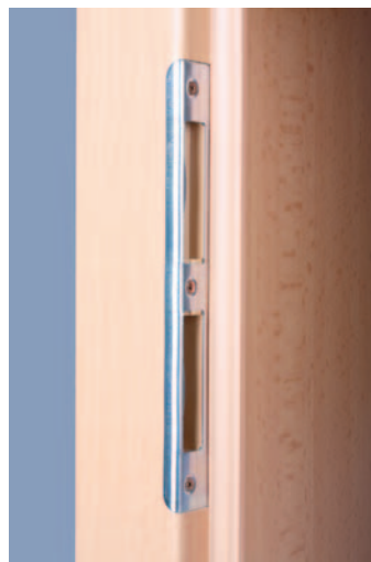
Detail připevnění protiplechu
