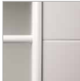
pohled na frézování
