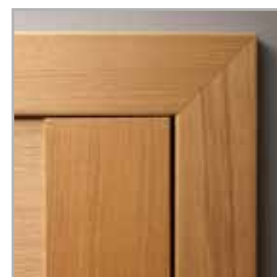
zářež DIN DUO, lišty spojované pod úhlem 45°
